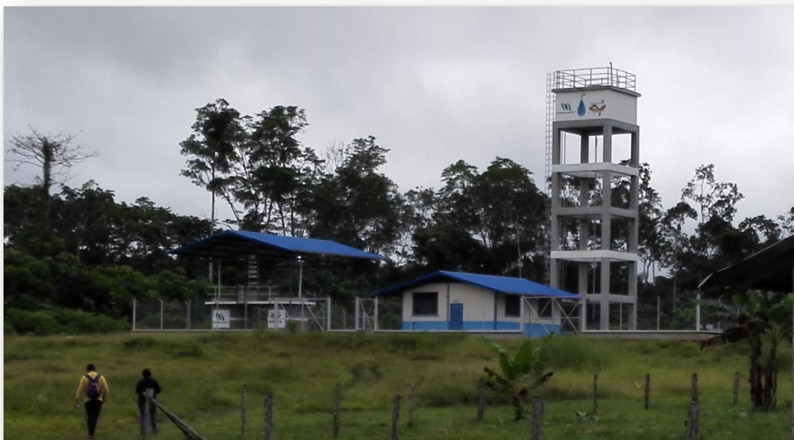
Imagen 24. Planta de agua potable en Centro Huiririma
