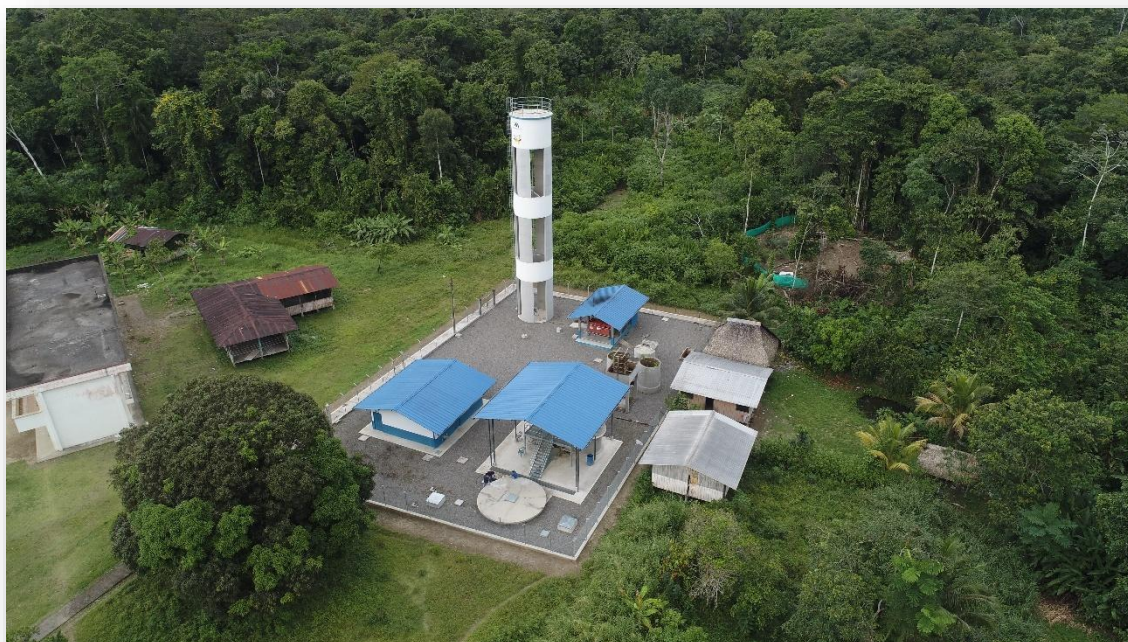
Imagen 25. Planta de agua potable en Puerto Quinche
