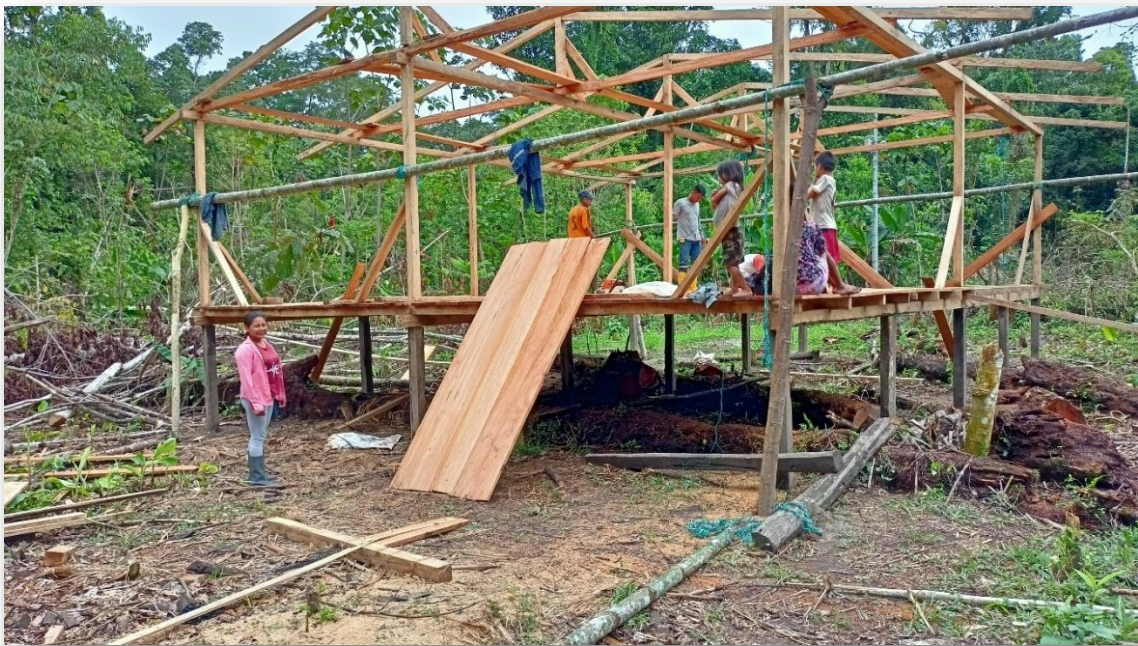
Imagen 27. Construcción de vivienda popular para grupos vulnerables.
