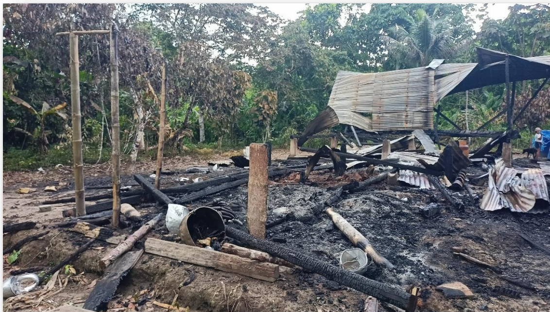
Imagen 2. Incendio estructural de vivienda en Santa María de Huiririma
